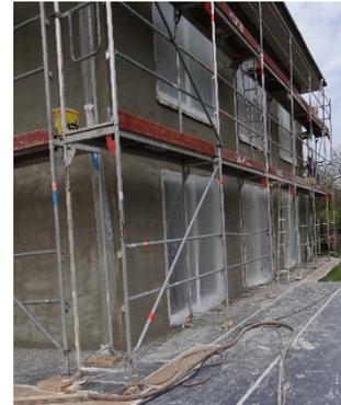
**Einsatzgebiet:** Abdeckkarton bei Verputzarbeiten unter Standgerüsten im Außenbereich bzw. als befahrbare Schutzlage unter Rollgerüsten im Innenausbau.
