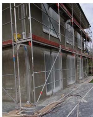
**Einsatzgebiet:** Abdeckkarton bei Verputzarbeiten unter Standgerüsten im Außenbereich bzw. als befahrbare Schutzlage unter Rollgerüsten im Innenausbau.
